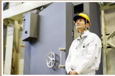
水密扉の前で説明する熊平製作所の川本直さん。この扉は東日本大震災クラスの地震にも耐える強度と、津波の浸入を防ぐ水密性、衝撃を防ぐ機能を兼ね備えています。
